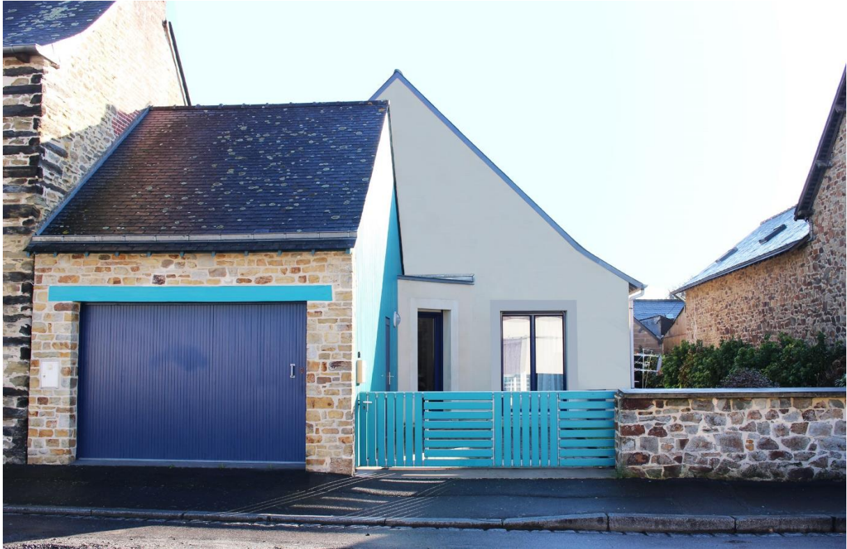
Un exemple de projet BIMBY : une construction neuve de plain-pied trouve sa place en centre bourg sur un terrain issu de la division du jardin d'une maison plus ancienne.
